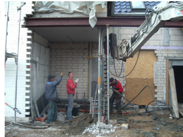
Teilabbruch / Rückbau, Gebäudeabfangung, vorbereitende Arbeiten Grundwasserabsenkung an einem Bauvorhaben in Dülmen
