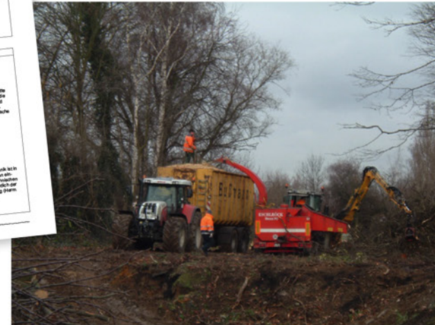
Vorbereitende Arbeiten an einem Bauvorhaben in Dortmund
